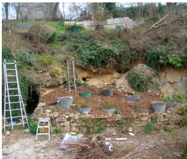
Figure 10 : exemple de versant sous-cavé de la configuration de type B1 « coteau sous-cavé » : deux entrées de cave à Creil (60) (Source : Ineris)
