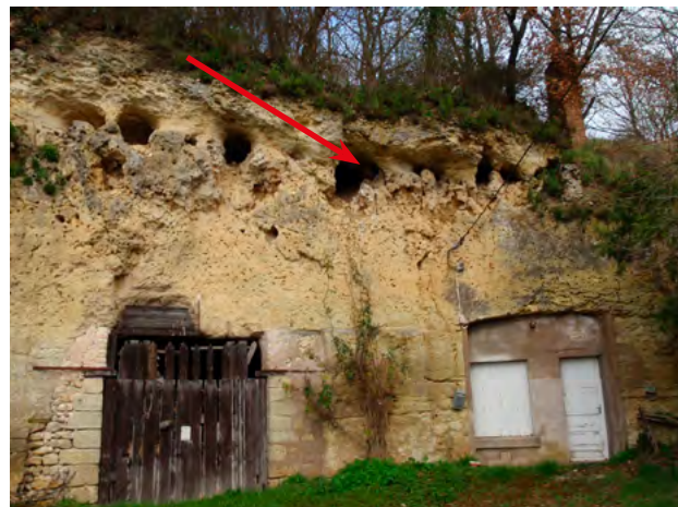
Figure 15 : zone de roche plus tendre picorée par les pigeons à gauche et terriers de blaireau au sommet du front à droite (Source : Cavités 37)
