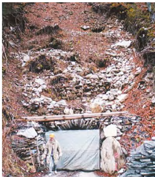
Figure 19 : couverture de type colluvion sur un site de coteau sous-cavé (ardoisière de Morzine, 74) (Source : Ineris)
