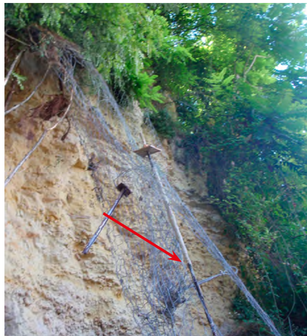
Figure 16 : exemples de boulonnage mal dimensionné à gauche (soit le boulon est trop long soit le trou foré n'est pas assez profond) et de mauvaise cimentation du boulon à droite (non présence de coulis sur toute la longueur du boulon) (Source : Cavités 37)
