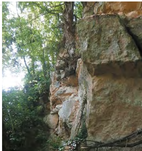
Présence de végétation (racines qui contribuent à l'élargissement de fissures et à la chute de pierres et de blocs)
