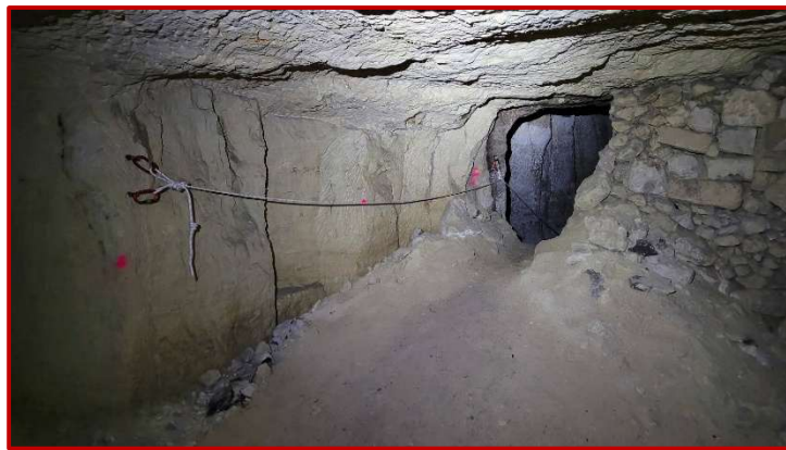
Mise en place d'une main-courante pour accéder à la galerie supérieure.
