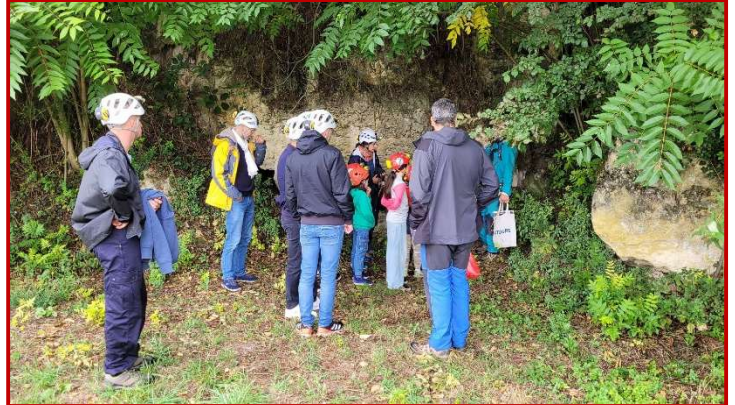
Petite halte devant l'entrée effondrée de la Fontaine Saint-Martin.
