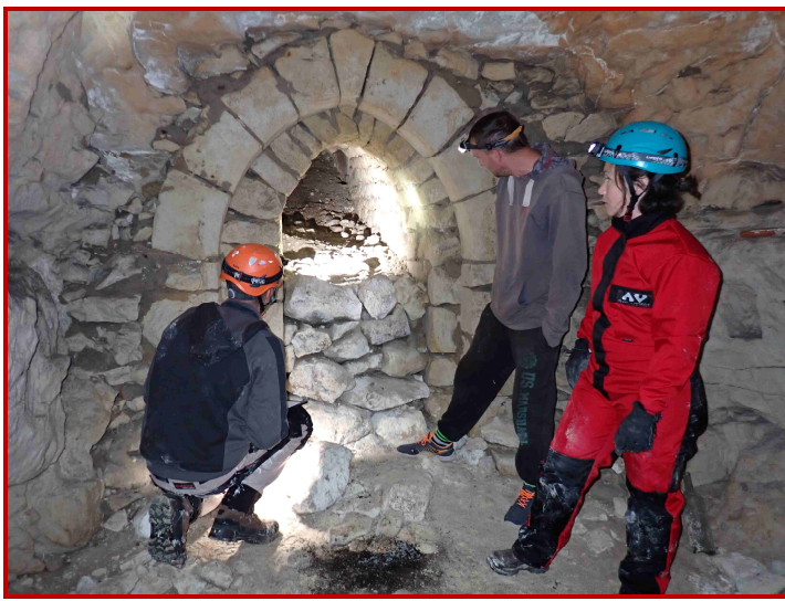
22 mai 2023 – Exploration du Souterrain-refuge du Château de Beauvais-Draché-37
