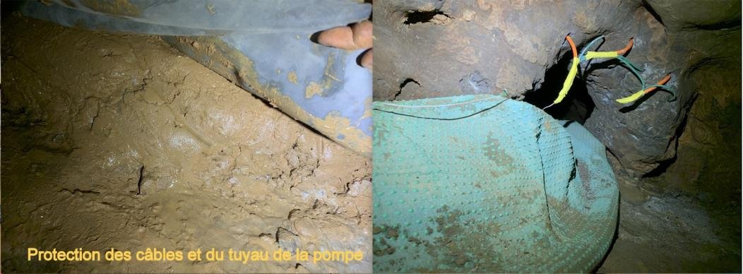
Protection des câbles et du tuyau de la pompe
