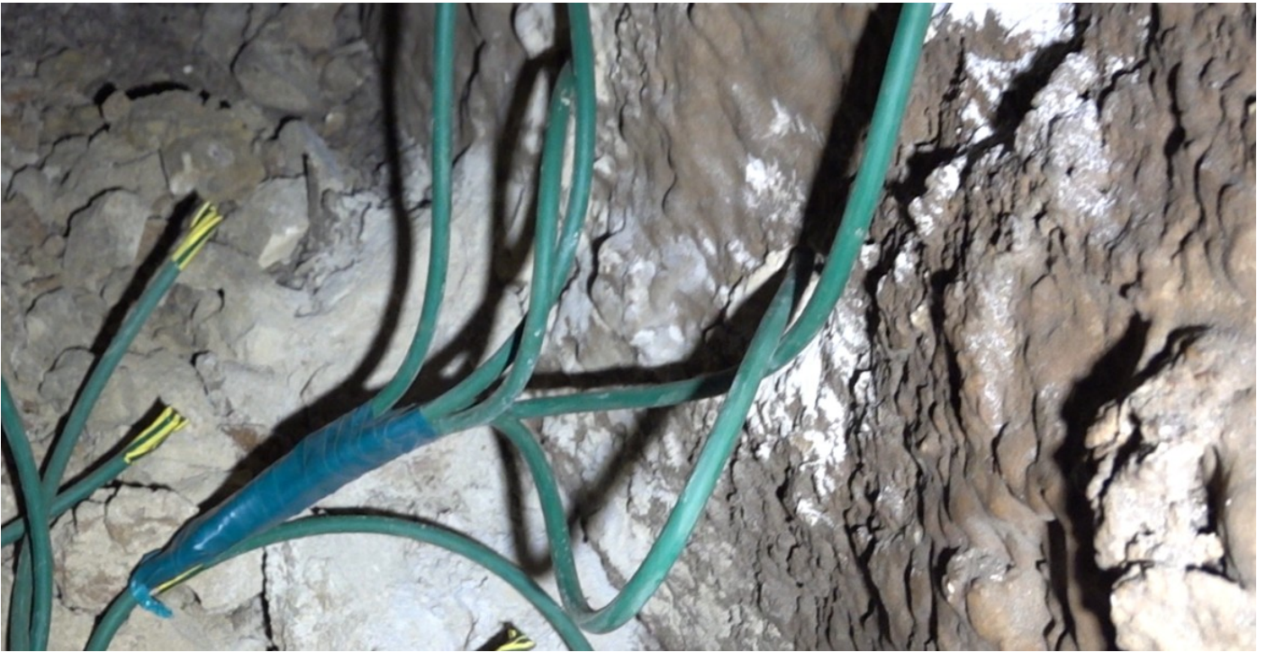
Mise en place du cordeau.
