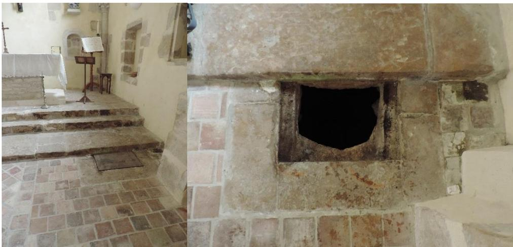
Un massif maçonné permet de réduire progressivement la largeur du puit (80x70cm environ), pour ne laisser qu'une ouverture de 50x40cm environ.
