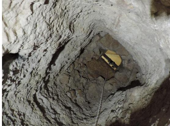
Le souterrain est creusé dans un calcaire dégradé, qui semble impropre à l'extraction de blocs de construction. L'ensemble des ciels visibles est perturbé par des fontis plus ou moins importants, faisant apparaître des profils de cloches d'effondrement.
