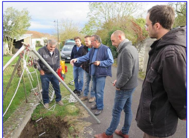
Mise en place d'un trépied afin de descendre à la verticale.
